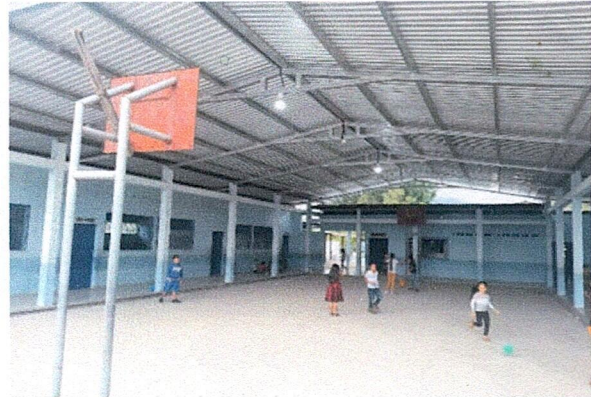
Foto 4: Mejoramiento de estructura de techo.
