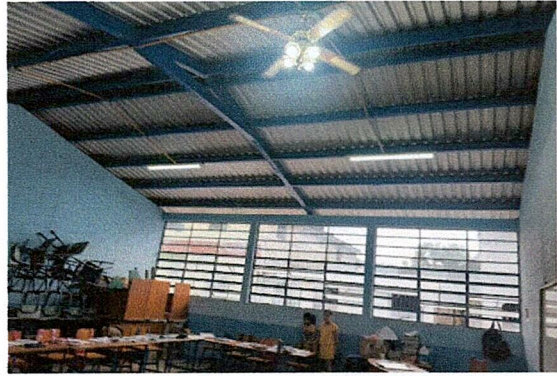
Foto 2: Reparación e instalación de energía eléctrica.
